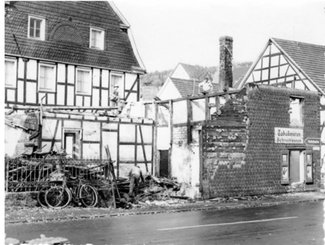
Abriss des Tabakwarenladens von „Höcks Trinchen“ Umbau der Kreuzung Siegburger Str.
