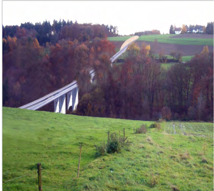
Eine Talbrücke zwischen Heiligenhaus Linde und Wiedenhof zerschneidet die Landschaft (Fotomontage E. Dommer)
